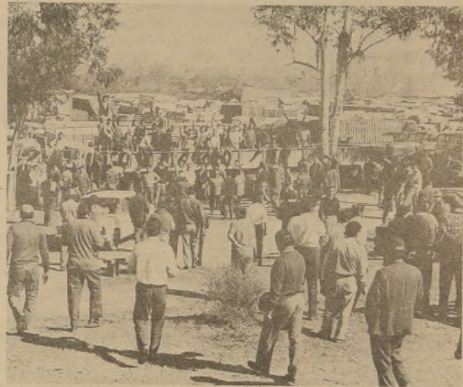
ACELERAN DISTRIBUCION DE ALIMENTOS. — Apresurando la reparación de sus vehículos, el gremio de transportistas ha puesto en faena la casi totalidad de los vehículos, los que están dedicados especialmente al transporte de productos alimenticios a los principales centros de consumo.
