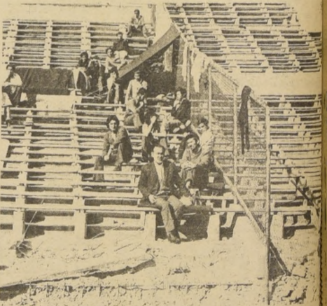
EN LA GALERIA bajo el marcador fue instalada improvisada carpa para protegerse del sol.
