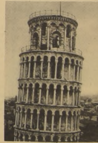
Parte superior de la Torre de Pisa, cuyas bases serán consolidadas mediante obras que se iniciaron en 1971. La famosa Torre aumenta su inclinación en un milímetro aproximadamente al año.
