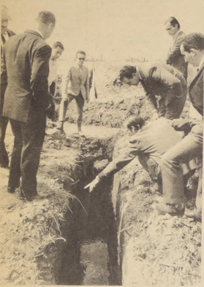
EL DIRECTOR EJECUTIVO del SAG (Servicio Agrícola Ganadero) Emiliano Ortega, junto a un grupo de especialistas en riego de la VI Zona, inspeccionan las obras de regadío y drenaje realizadas en los Asentamientos del Área Norte de Santiago.
