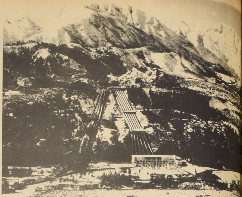
CENTRAL Hidroeléctrica ABANICO de 136.000 KW.
