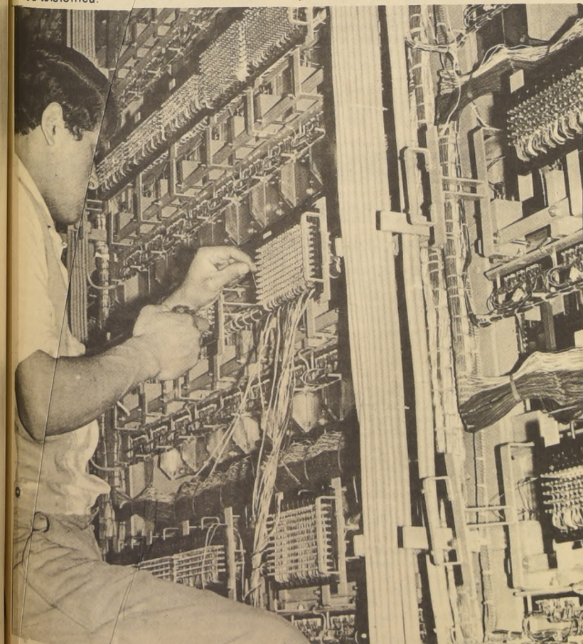
Un obrero especializado trabaja en el montaje de uno de los equipos que han sido instalados en las nuevas centrales. Aproximadamente el noventa por ciento del servicio telefónico del país es automático.
