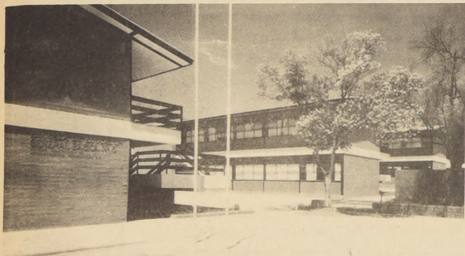
ESCUELA N° 5 "El Peral", de la Comuna de Puente Alto; se trata de un proyecto de experimentación a base de estructura metálica en sus dos pisos.
