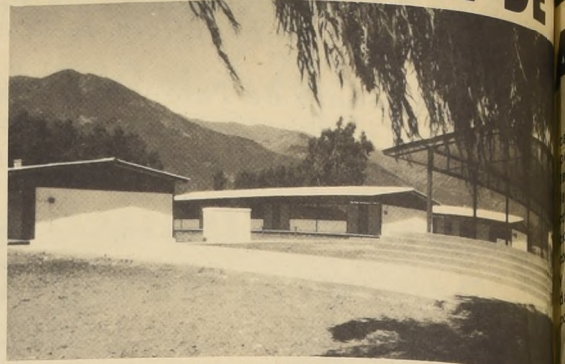
ESCUELA de Popeta, en la Comuna de Rengo. Esta Escuela fue construida con un valioso aporte de la Ilustre Municipalidad.
