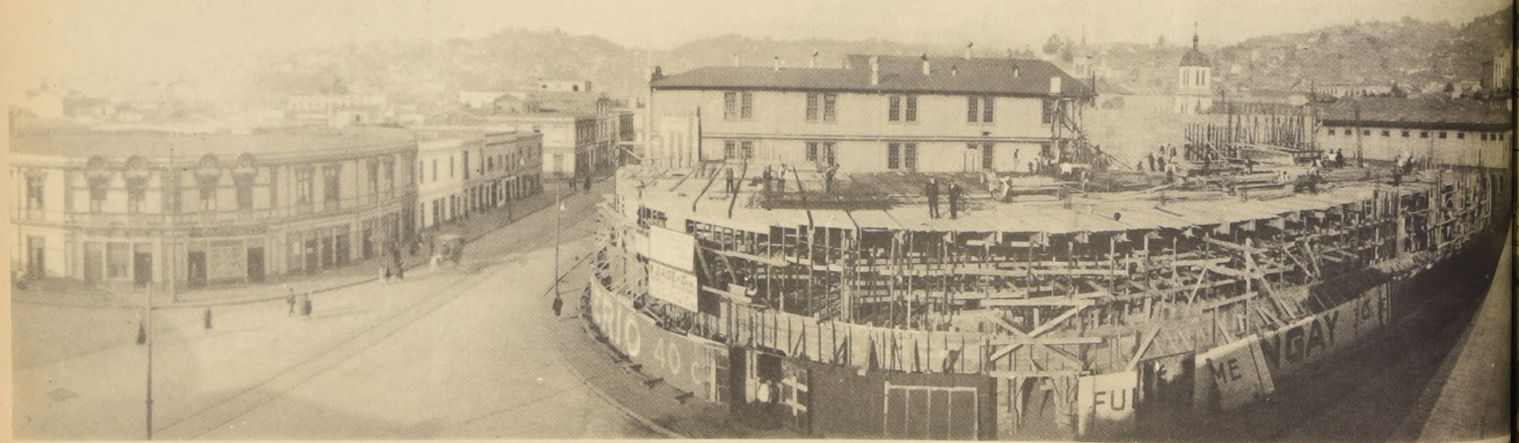
Fábrica en construcción
