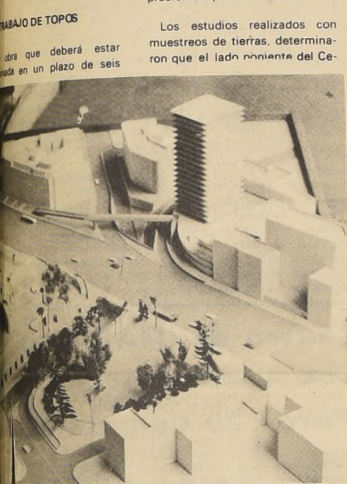
UNA VISTA DESDE Diagonal Paraguay muestra el Paso Inferior Santa Lucía, que cruzará por debajo de Alameda. A la derecha Viciu Mackenna y entre los árboles el paso para peatones que unirá la Plaza y el Cerro Santa Lucía, a la izquierda.
