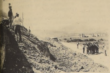
UNA REUNION EN EL CAMINO. Un aspecto de la visita que realizaron el ministro de Agricultura, Hugo Travelli, y el titular de Obras Públicas, Eugenio Celedón. Los Secretarios de Estado y comitiva se detienen, en el camino Copiapó-Salamanca que está siendo reparado por el sistema de trabajo comunitario para dialogar con los trabajadores.
