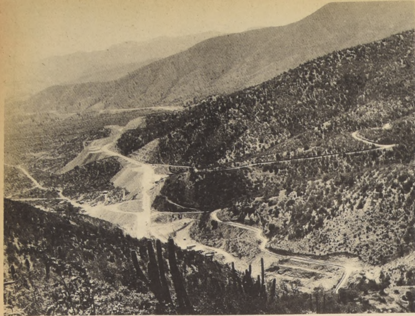
Vista panorámica del lugar donde se terminan las faenas de construcción del Túnel que unirá Valparaíso con Santiago.
