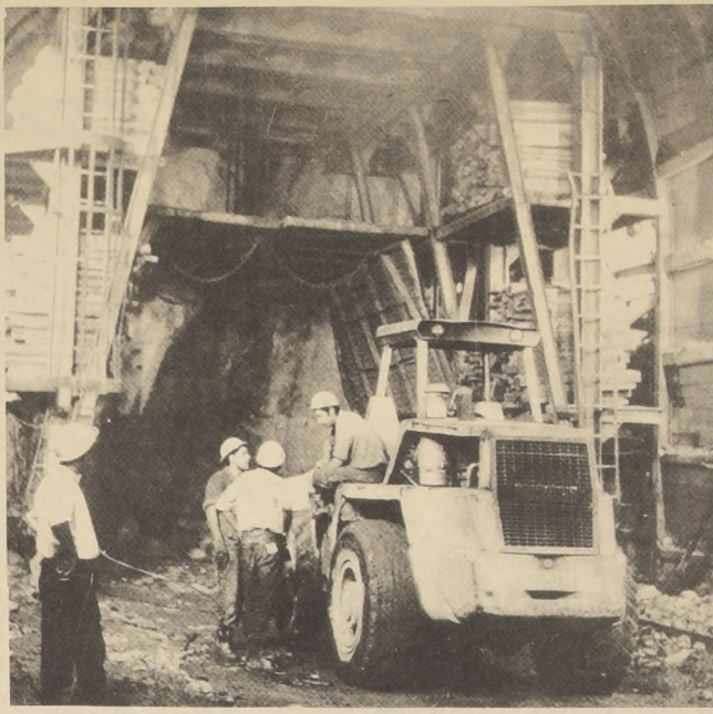
Mañana Hora Cero de faenas de excavación del Túnel Lo Prado, vía que acortará en 45 minutos el viaje entre Santiago y Valparaíso.
