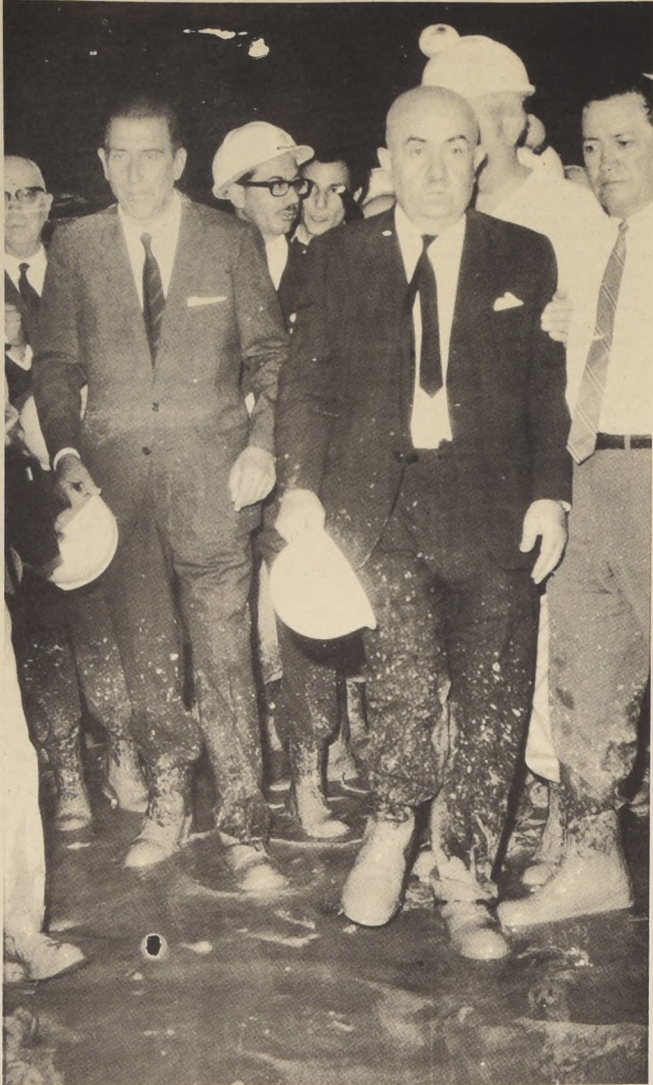
Con paso firme, el Primer Mandatario y su comitiva atravesaron de extremo a extremo el Túnel Lo Prado, sin prestarle atención al barro que ensucia sus ropas.
