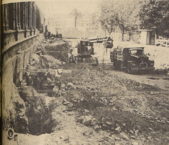
Trabajos de excavación en el costado del Cerro Santa Lucía han obligado
