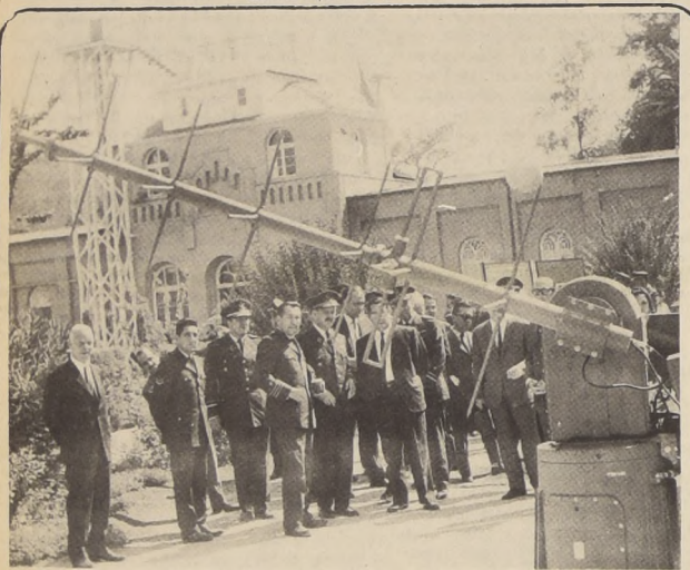
Antena orientable. Parte del moderno equipo de la red nacional de estaciones de recepción de datos meteorológicos vía satélites
