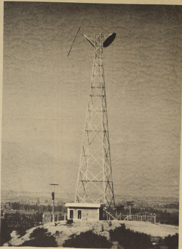
Repetidor de microondas "La Requiñua" del sistema terrestre de comunicaciones por satélite.
