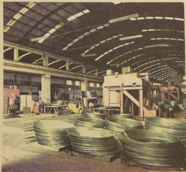
LAMINACION de rollos de cobre, aluminio, y latones, para la producción de radiadores de automóviles, ampolletas, artefactos electro-domésticos e industrias varias.
