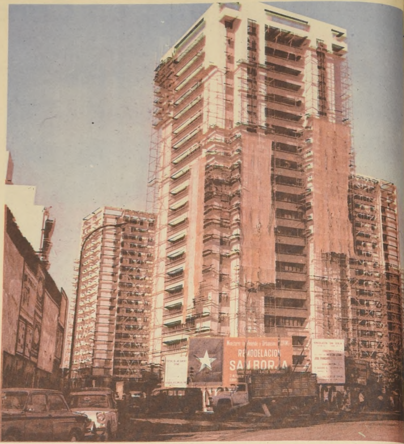
SUSTENTADO por placas colaborantes que forman cuatro pilares en los vértices, por la superficie de pisos con viguetas pretensadas y una losa con armadura de malla soldada, dan la característica principal de la torre N° 11 de la remodelación San Borja. Arquitectos: Hugo Gaggero y Margarita Pisano. Construye J. Francini y Cia. Ltda.
