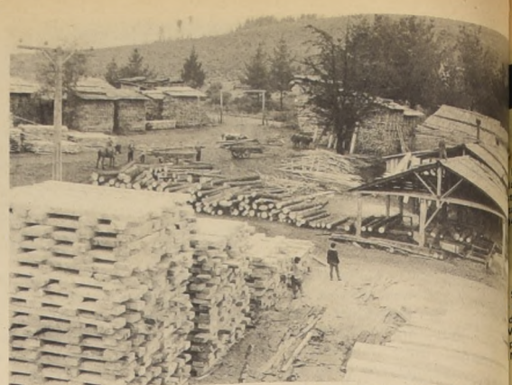
PULLALLY. Obras de infraestructura de mucho valor para los nuevos propietarios de este predio se han realizado en diferentes rubros. Asimismo marcan aserradero que proporciona maderas para las viviendas y para las necesidades de un predio de gran extensión.
