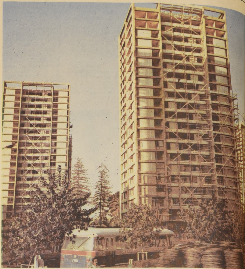
Aspecto de 2 de las cuatro torres que construye la Empresa Constructora Abalos y González
