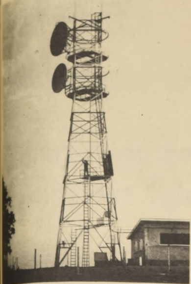
Torre de microonda de Recreo Alto, una de las terminales de este moderno sistema de comunicaciones que une a Santiago con Valparaíso. Chile fue el primer país sudamericano de la costa del Pacífico en emplear las microondas en las comunicaciones telefónicas.
