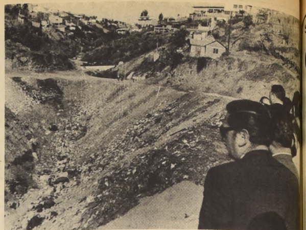
En este lugar se construirá una cancha de fútbol. Ya el terreno está siendo abovedado y se pretende, además de una cancha, contar con un escenario para el básquetbol, como una piscina para los nadadores. Los terrenos están dados en Quebrada Verde, en el sector denominado Valle Verde, que también fueron visitado por la autoridad de bierno.
