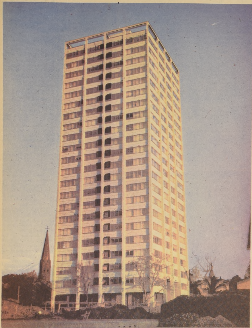
La torre N° 12 de la Remodelación San Borja, construida con tres meses de anticipación a lo convenido, lucirá elegante en medio de un gran parque interior destinado a unir todas las torres. Se consulta, además, en ese mismo sector, una plaza de esparcimiento y entretenimiento y una bandeja bajo nivel para estacionamiento de 60 vehículos. Arquitectos: Sergio Larrain G. M., Ignacio Covarrubias S. y Jorge Swinburn P.
