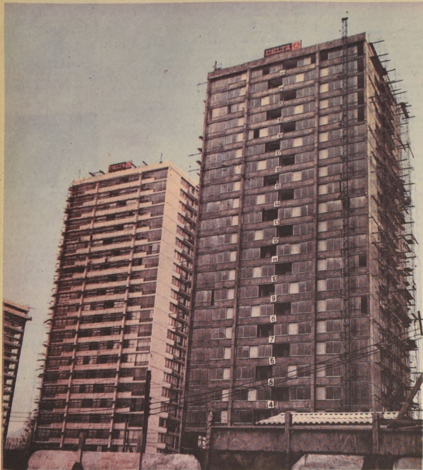
Aspecto de las tres torres que construye la Empresa de Viviendas Económicas Gama S.A. en la Remodelación San Borja. Arquitectos Bolton, Larrain, Prieto, Lorca, Ingenieros calculistas, Muggli, del Sol, Vogel.
