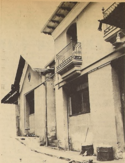
Su estado es deplorable, ruinoso. Los hábitos de los bares del lugar la tienen convertida en toilette...
