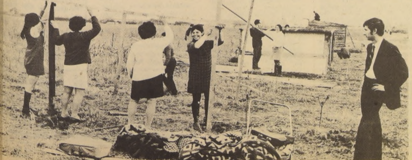
Las mujeres también trabajan para instalar sus mejoras. Debieron ocupar sus terrenos para defenderlos de los ocupantes ilegales.
