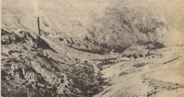
Vista general de la Fundición de Caletones.
