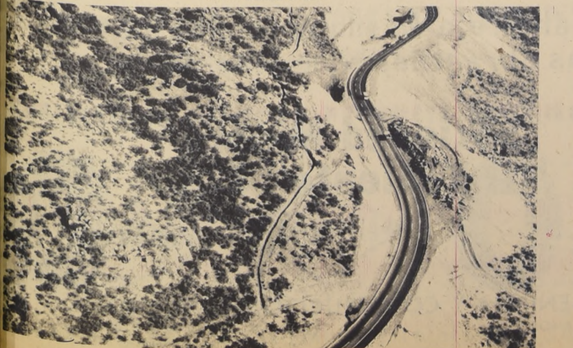
Carretera recién terminada entre Rancagua y Nueva Colón.
