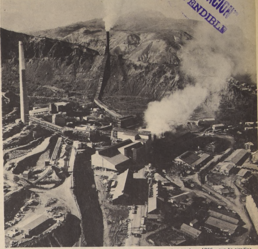
Obras por un valor de 241 millones de dólares serán inauguradas hoy por el Presidente de la República, en el mineral El Teniente. Con este acto se pone fin al plan de expansión iniciado en 1966 y que ha significado la inversión de alrededor de 800 millones de dólares. (Amplias Informaciones Páginas Interiores)
