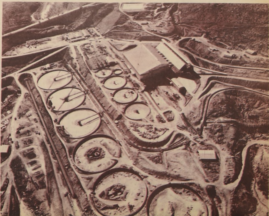
Espesadores de relaves del Concentrador de Nueva Colón, de la Sociedad Minera El Teniente.
