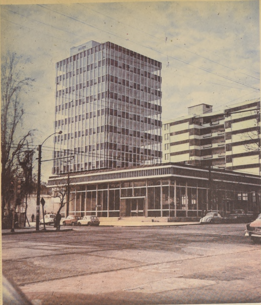
El moderno edificio del Banco de Chile, Sucursal Providencia y Montolín. Una gran placa de doble altura, desprovista casi totalmente de pilares y absoluta transparencia para las funciones propias del Banco y una torre que emerge de ella en un cuadrado de 15 por 15 metros y diez pisos de altura conforman los elementos básicos de esta composición arquitectónica.
