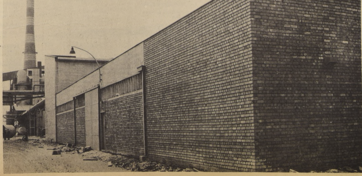
Vista exterior del edificio donde opera la Planta de Selenio de la Empresa Nacional de Minería y el cual forma parte del complejo industrial que esta institución posee en Ventanas.
