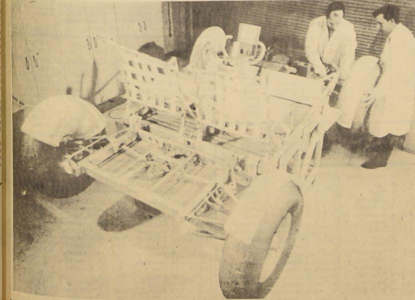
SEATTLE, WASHINGTON — Los ingenieros hacen los ajustes finales en un vehículo que será utilizado en la exploración lunar. En las pruebas, el vehículo soportó exitosamente vibraciones similares a las que tendrá que sufrir en la superficie selenita. (Radiofoto UPI).
