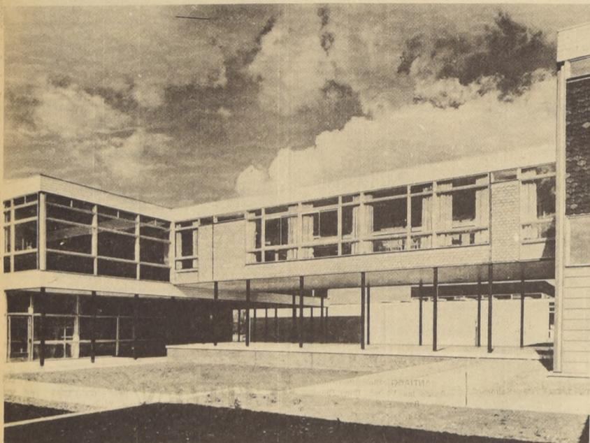
CLASP — sistema industrializado británico para la construcción de escuelas — se basa en el uso de elementos normalizados, con diversas posibilidades de ensamblaje, de manera que es posible reducir edificios de
