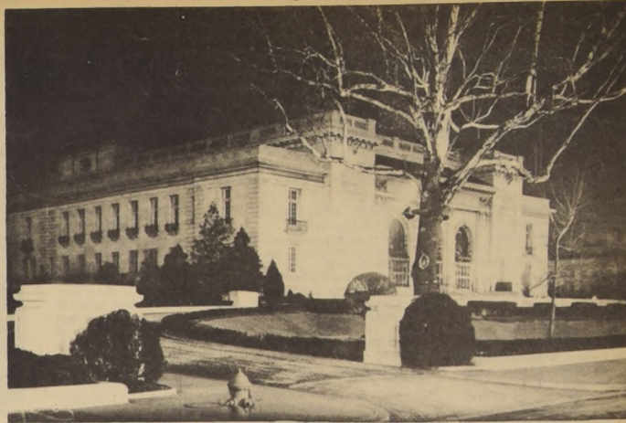
Edificio de la Unión Panamericana en Washington
