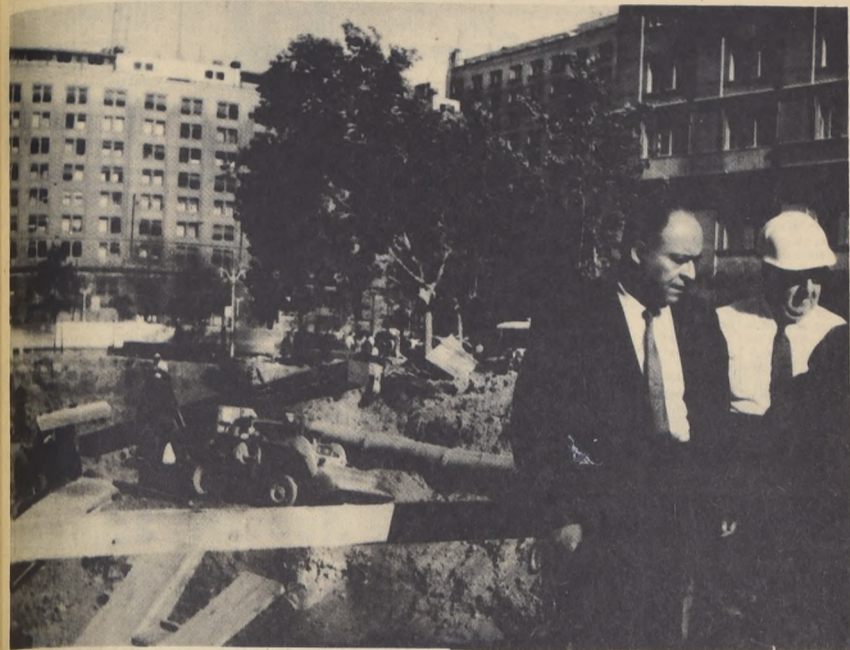
MINISTRO BARRAZA. Recorrido completo a las obras del Metro. Se dará impulso inmediato a la línea 2, que servirá a los barrios populares.
