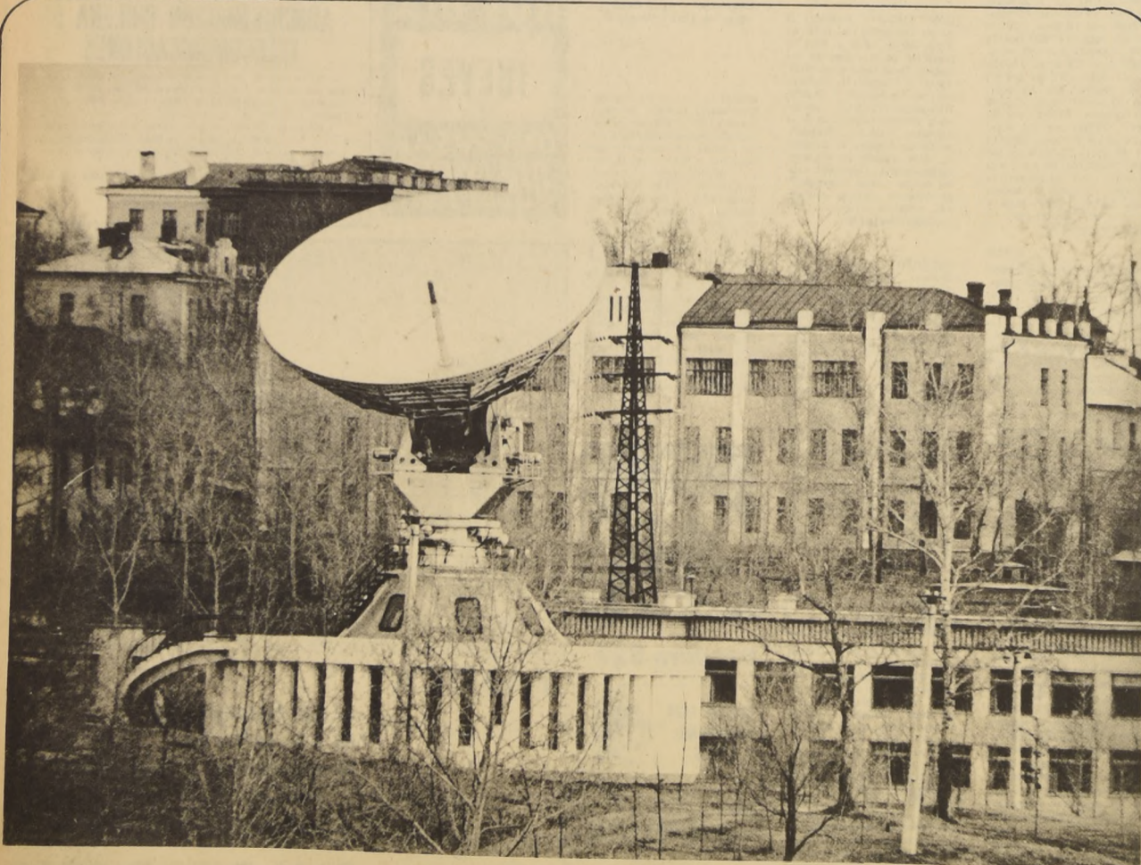
Federación Rusa. Ciudad de Jabárovsk. Antena de la estación televisiva "Orbita", que recibe emisiones mediante el sistema de los satélites artificiales.
