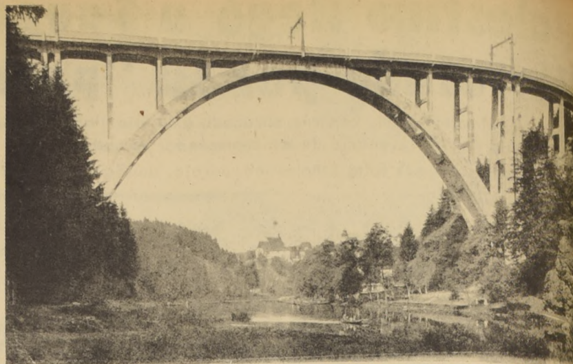
Puente ferroviario de Bechyné
