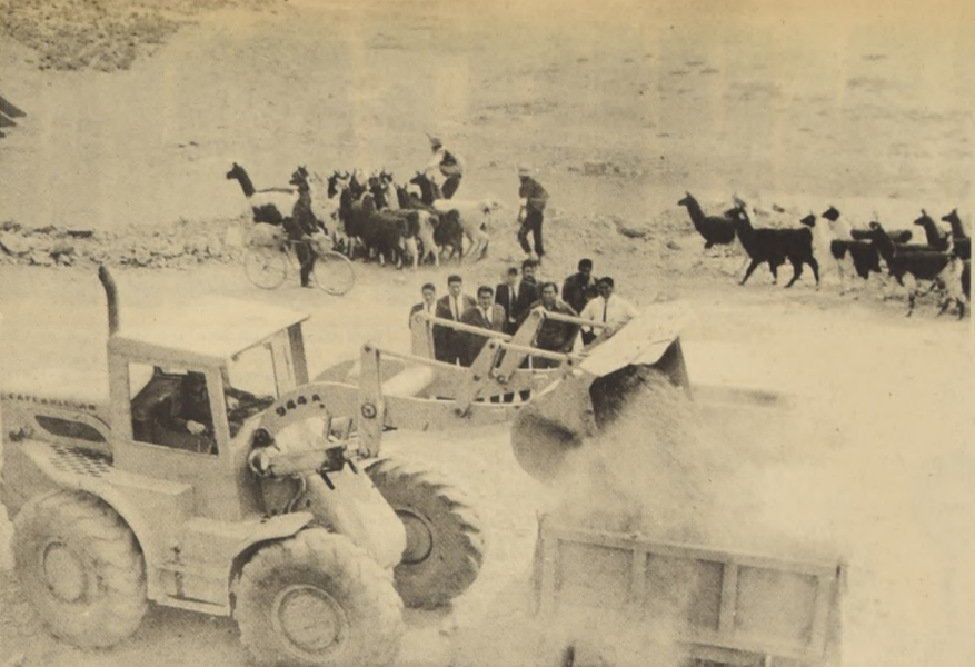
Así, entre llamas y polvo, a cuatro mil y tantos metros de altura, se están haciendo los primeros trabajos para la construcción de la carretera Iquique-Oruro.
