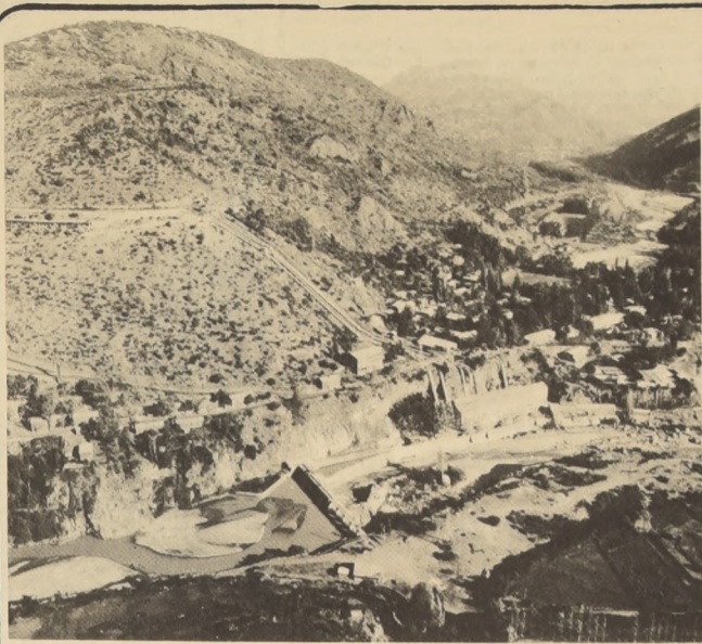
El Teniente; una mina subterránea
