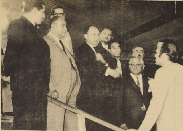
PASCUAL BARRAZA, Ministro de Obras Públicas, junto a autoridades de la Provincia de Nuble inspecciona el actual estado del Gimnasio Cubierto de Chillán, cuya terminación prometió el Secretario de Estado concluir en breve plazo.
