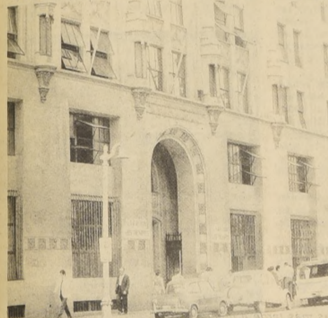
Como un desafío al tiempo LA NACION levanta la firme estructura de su edificio que empezó a construirse en 1928.
