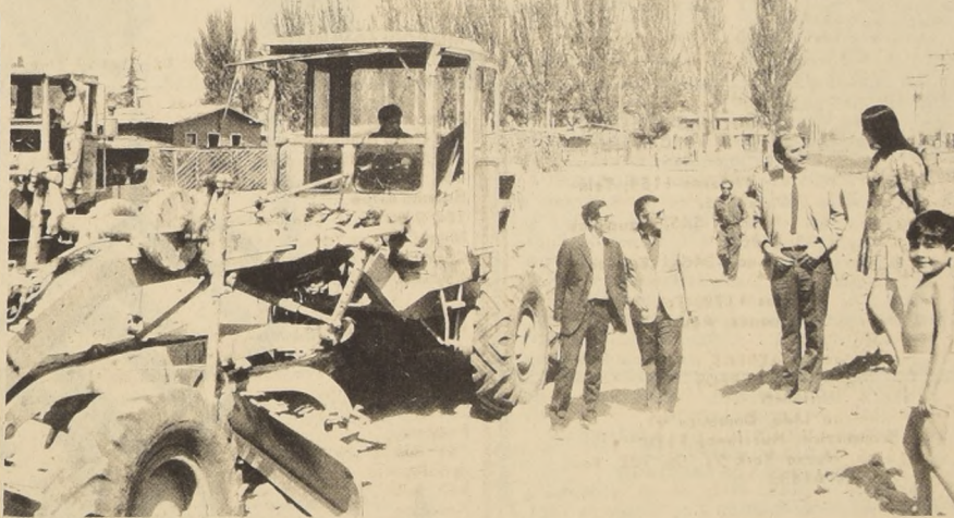
OBRAS URBANAS. Hernán Araya, coordinador de la oficina Operación de Emergencia de la Vivienda, acompañado de María Inés Marques, ingeniero civil del mismo departamento, realizaron una visita a
