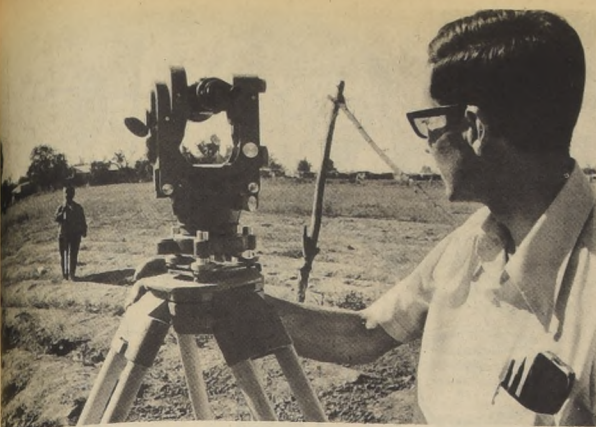
CUMPLIENDO EL PLAN DE LA OPERACION de la Vivienda, técnicos y empleados han sumado los pobladores. En la fotografía, el Delegado de la Corporación de Obras Urbanas, Manuel Hidalgo, en plena labor de topografía.
