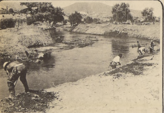
TRABAJOS de defensa fluvial que se realizan en el río Mapocho, sector Pudahuel, sirven, al mismo tiempo, para dar ocupación remunerada a centenares de cesantes.
