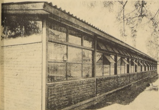
Iniciada los primeros días de Marzo, la Escuela N° 44, de Lo Espejo, se encuentra terminada.
