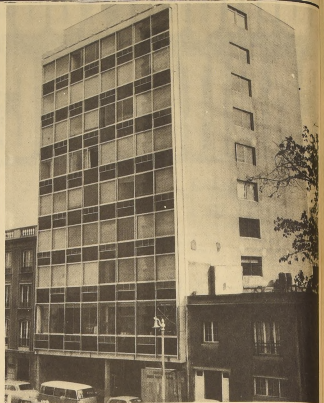
Fachada principal del Centro Médico "Monseñor Carlos Casanueva" ubicado en Marcoleta 377. Edificio de 10 pisos de altura con piso zócalo y subterráneo. Arquitectos Juan Echeñique G. y José Cruz C.
