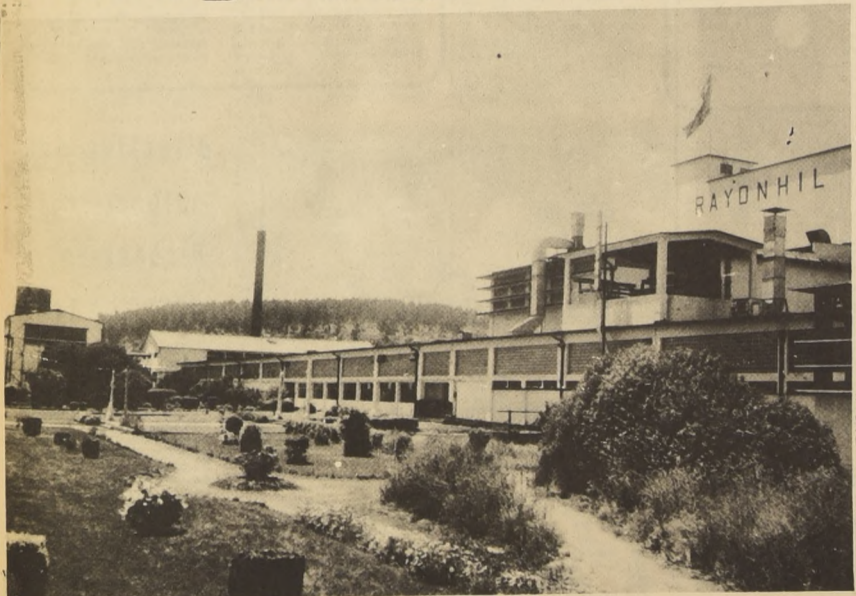
PLANTA DE RAYONHIL, firma que está logrando importantes éxitos en el campo de las exportaciones, especialmente hacia Perú. Las magníficas perspectivas que abre esta actividad han obligado a ampliar las instalaciones de la firma.
