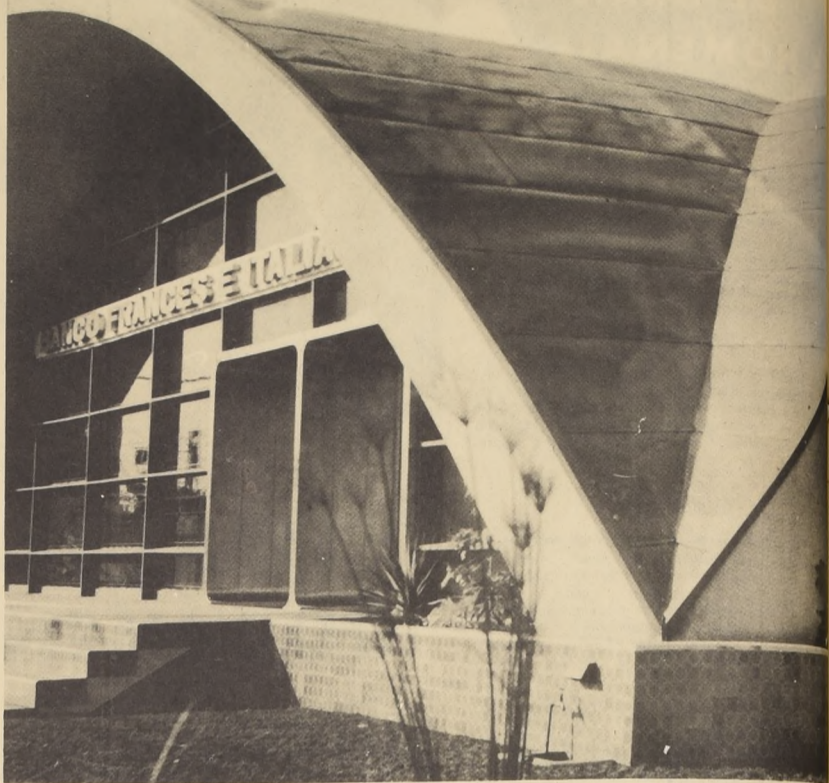
Edificio para sucursal del Banco Francés e Italiano en Gran Avenida. Dos arcos por encima, conforman el techo que ha sido cubierto con planchas de cobre. Arquitectos: Giorgio Enerjici, Jorge López y Luis Silva.
