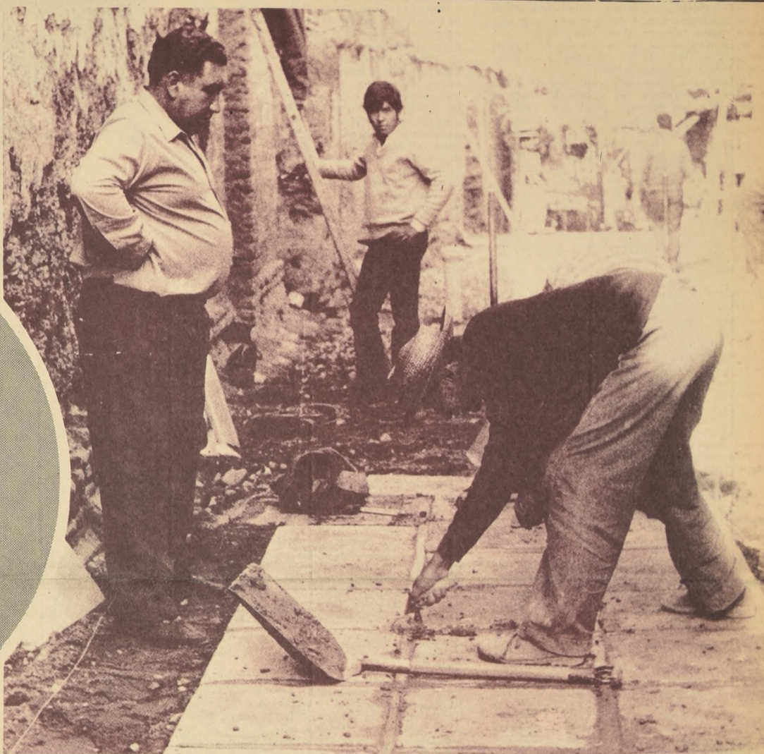
TRABAJO VOLUNTARIO DEL ALCALDE.—Desde las primeras horas de la mañana de ayer el Alcalde de Santiago, Ignacio Lagos, trabajó voluntariamente reconstruyendo las ruinosas viviendas de una cité ubicada en calle Jofré 314. Junto a los habitantes y funcionarios de la Corporación Edilicia, que también colaboraron voluntariamente, el Alcalde Lagos colocó fonolas en el techo, pintó murallas, cooperó en la
