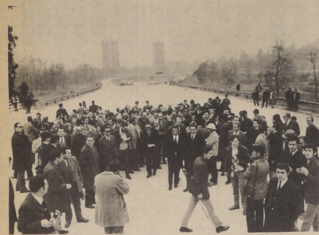
El complejo vial de Vitacura ha sido inaugurado y las autoridades avanzan por el puente Lo Saldao sobre el río Mapocho, rudo central de la obra que permite el empalme de dos avenidas vitales del tránsito capitalino.
