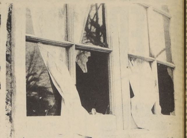
Con todos los vidrios destruidos quedaron las ventanas de la casa de la calle Coronel Alvarado 2711, donde Ronald Rivera y su banda resistieron durante 6 horas el asedio de la policía.
