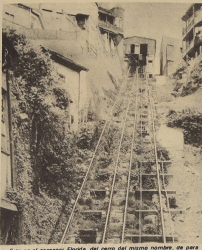
Esta es el ascensor Florida, del cerro del mismo nombre, de para hace 15 días por fallas técnicas. La Junta Vecinal del cerro desea que la Municipalidad lo propicie tal como se hará con doce ascensores más, por medio de CORMUVAL.
