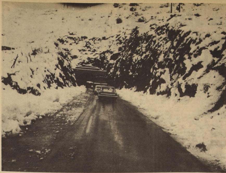
ALREDEDOR del mediodía, una Compañía del Regimiento de Ingenieros Ferrocarrileros "Puente Alto" colaboró en el despeje de la carretera a la altura de la Angostura de Paine. De este modo el túnel del mismo
