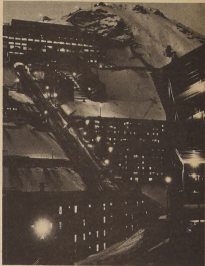
DOS METROS de nieve cubrieron a "El Teniente". Sin embargo la alimentación eléctrica de la instalación fue reforzada sin que se paralizara su producción.
