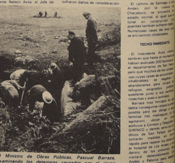
El Ministro de Obras Públicas, Pascual Barraza, examinando los deterioros causados por el sismo en el acueducto Las Vegas en Pachacama.
