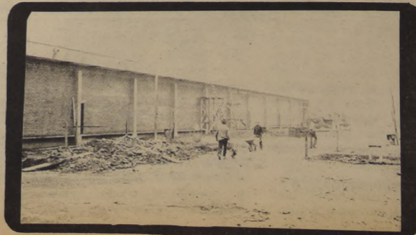
Pese al mal tiempo los trabajos no se han detenido.
