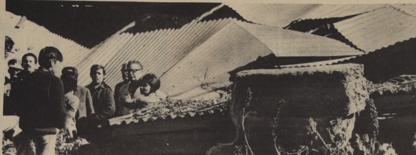
Señalando el camino hacia las ruinas de una escuela destruida durante el terremoto en la zona de Quillota.
