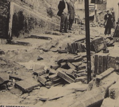
EL VICEPRESIDENTE de CORHABIT, Alejandro Rodríguez, conoce los daños causados por el sismo, en el terreno.
