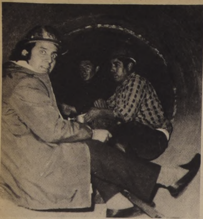
EL SUBSECRETARIO de Obras Públicas, Roberto Cuéllar, en el interior de la aducción Las Vegas, que nutre de agua potable al sector céntrico de Valparaíso y otras localidades de la provincia. En esa ciudad, hacia donde viajó para imponerse del ritmo en que se efectúan los trabajos de reparación, Cuéllar pidió a los obreros mayor esfuerzo aún que el desplegado para subsanar pronto el problema de abastecimiento de agua producido por el sismo.
