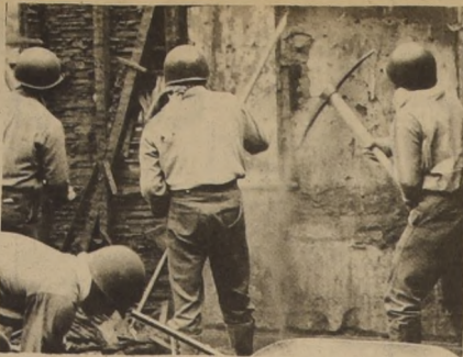
SIN DESCANSO trabajan los hombres de la Armada de Valparaíso demoliendo los edificios que averió más gravemente el terremoto, previendo nuevas desgracias.
