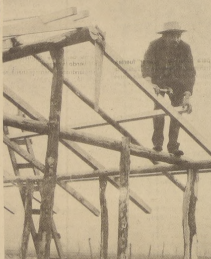
UN POBLADOR de La Liga en plena faena de reconstrucción, con maderas que él mismo ha recolectado.
