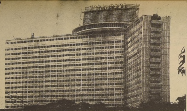
HOTEL NUEVO OTANI, el edificio más alto de Tokio, a prueba de terremotos. Sobre su techo se halla un restaurante giratorio que hace una revolución completa cada hora.
