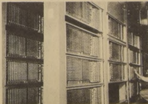
Vista parcial de una Central Telefónica Automática "Pentaconta" similar a la Central adquirida por la Ciudad Ecuatoriana Riobamba.
