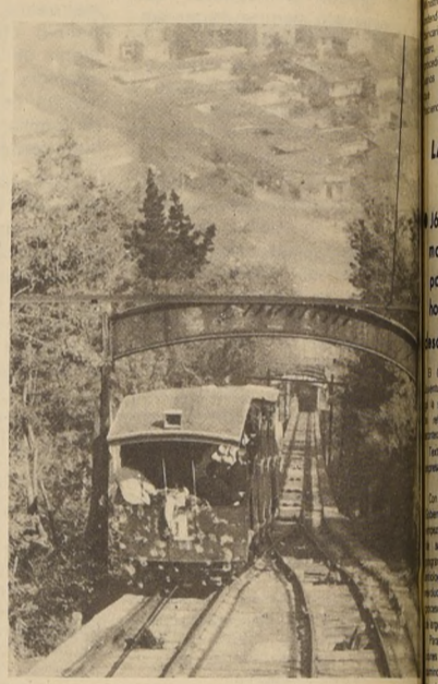
EL FUNICULAR repleto de gente, oaja el cerro hacia donde han ido aquellos que desean estar un poco lejos del ruido de la capital. Los trencitos sirven a la comunidad desde 1925 y para que ésta pueda suceder nueve trabajadores realizan diversas labores sacrificando sus días festivos y domingos.
